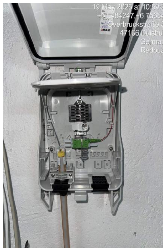
1. Foto von der Installierter HÜP
