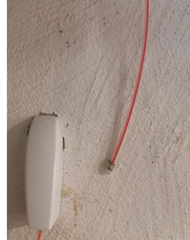
4. Gasdichte Verschlusskappe Mikrorohr
