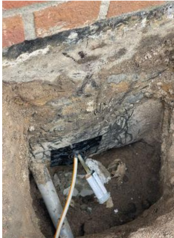
2. Detailaufnahme Ringraumdichtung (Hauseinführung)
