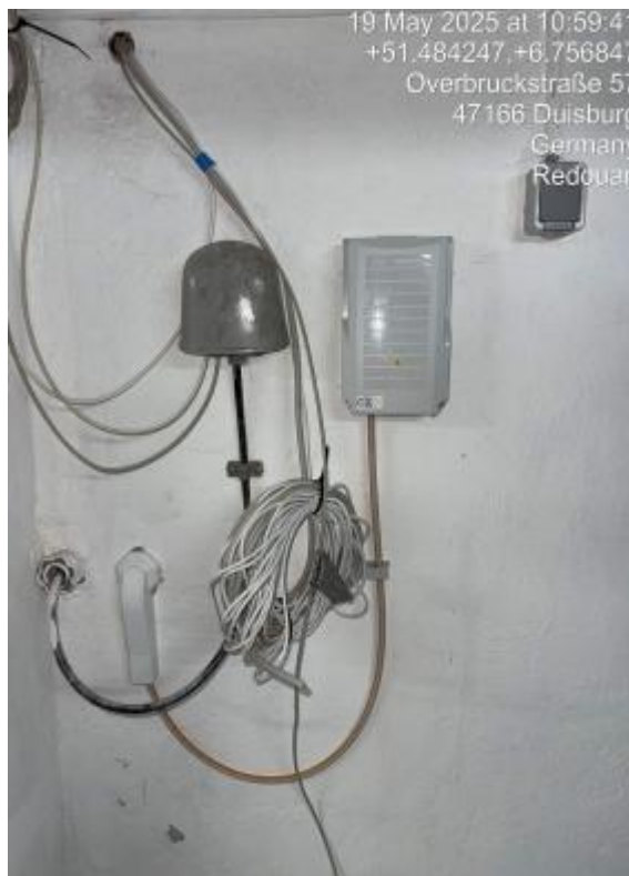
1. Foto von der Installierter HÜP
