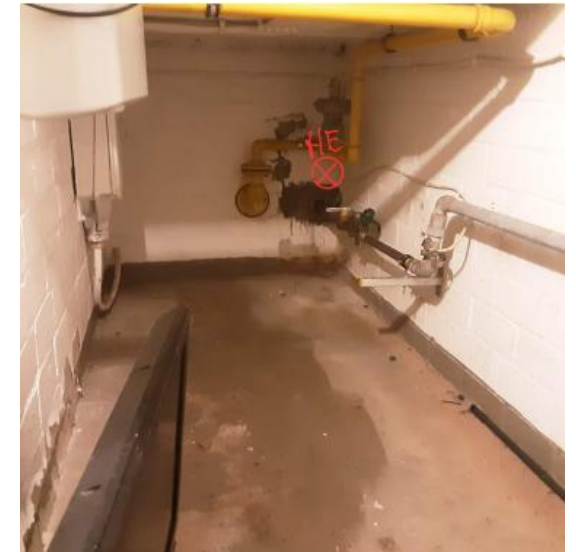
3. Geplante Position des Hauseinführung (innen und außen)
