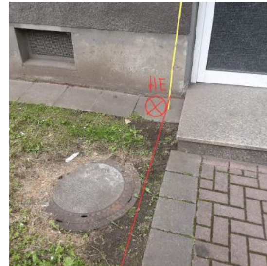
3. Geplante Position des Hauseinführung (innen und außen)
