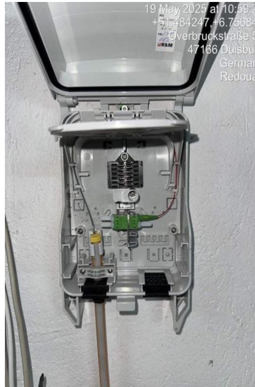
1. Foto von der Installierter HÜP
