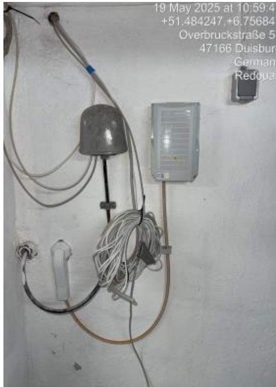
1. Foto von der Installierter HÜP
